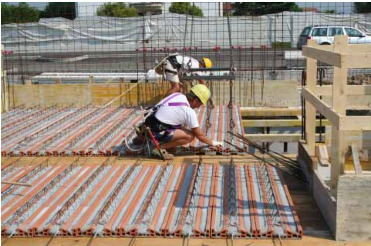
Esempio di posa di prefabbricati con l'uso di cordino di posizionamento
