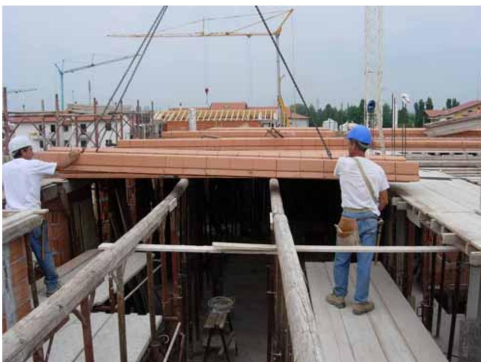
Posa dal basso di un solaio in lastre di latero-cemento
