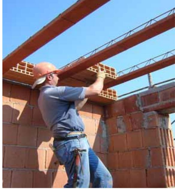
Posa dal basso di un solaio a travetti e pignatte: si nota la posizione ergonomicamente incongrua, che potrebbe essere risolta prevedendo di procedere con il montaggio di file complete di pignatte, anziché predisporre anticipatamente tutti i travetti. In tal modo il montatore potrebbe sporgersi con il busto oltre il livello di posa senza impedimenti.
