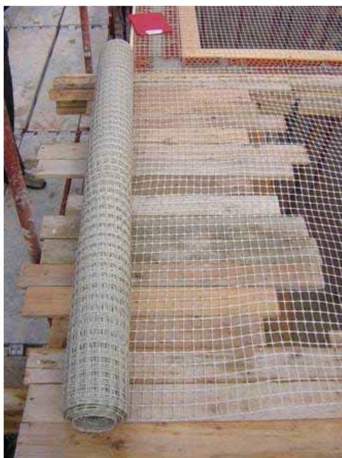
Esempi di utilizzo di reti in materiale plastico poste sopra il banchinaggio
