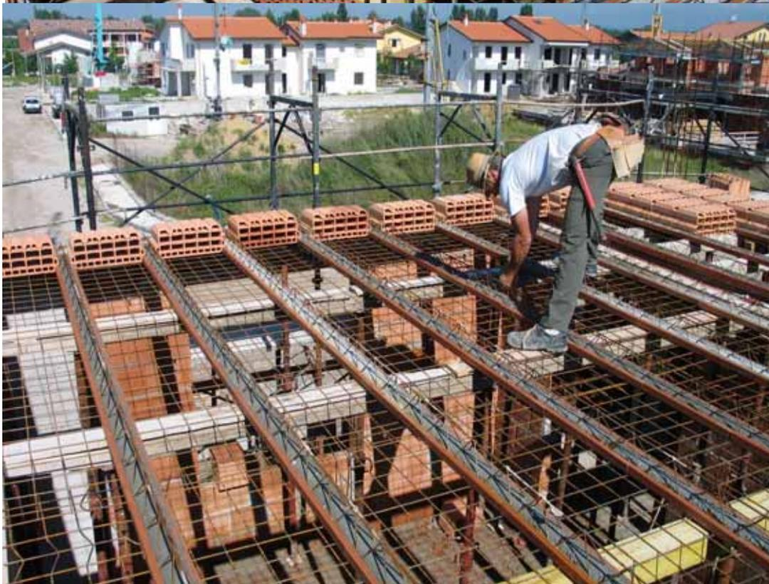
Esempio di utilizzo di reti elettrosaldate poste sopra il banchinaggio
