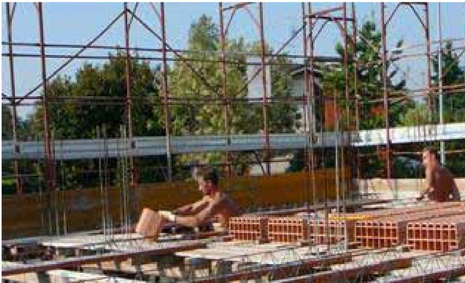
Posa dal basso di un solaio a travetti e pignatte: la soluzione è facilitata da una modifica del processo tradizionale, prevedendo cioè di procedere con il montaggio di file complete di pignatte, anziché predisporre anticipatamente tutti i travetti. In tal modo il montatore può sporgersi con il busto oltre il livello di posa senza impedimenti.
